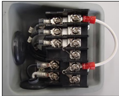
変更後のブレーキ用電源装置内蔵端子台
